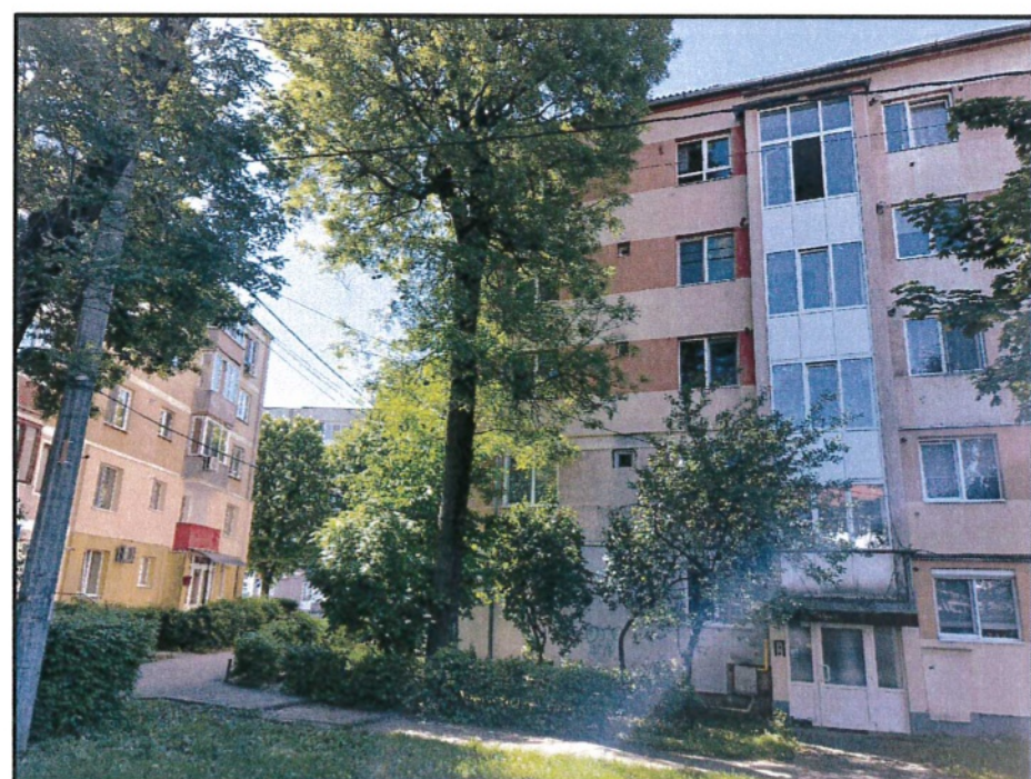
FATADA NORD - ACCESUL IN CASA DE SCARA A IMOBILULUI
